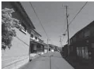
土壁がある町並み
