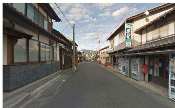
【図 32：アスファルト舗装の道】
