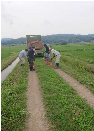
交付金を活用した 農道補修の様子
