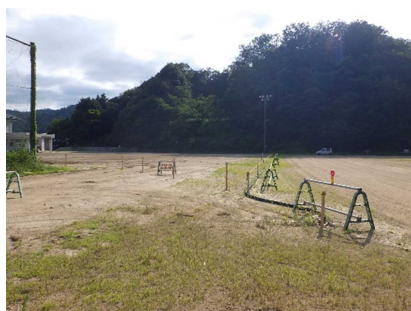
旧岩屋小学校解体撤去工事（更地になった状態）
