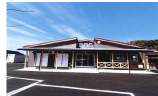
(新築した温江区公民館)
