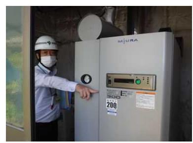
農産加工所蒸気ボイラー取替工事
