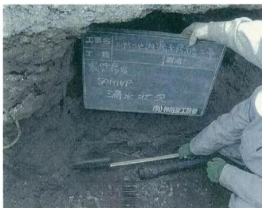
東日本大震災における水道管の被害状況（東日本大震災水道施設被害状況調査最終報告書より）
