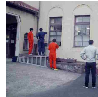
目視による外壁の調査。ひび割れの位置、長さ、深さを計測しました
