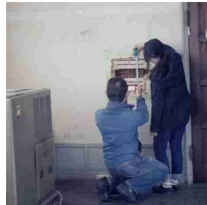
内壁調査。土壁がどのような仕様となっているか、一部を剥がして調査しました
