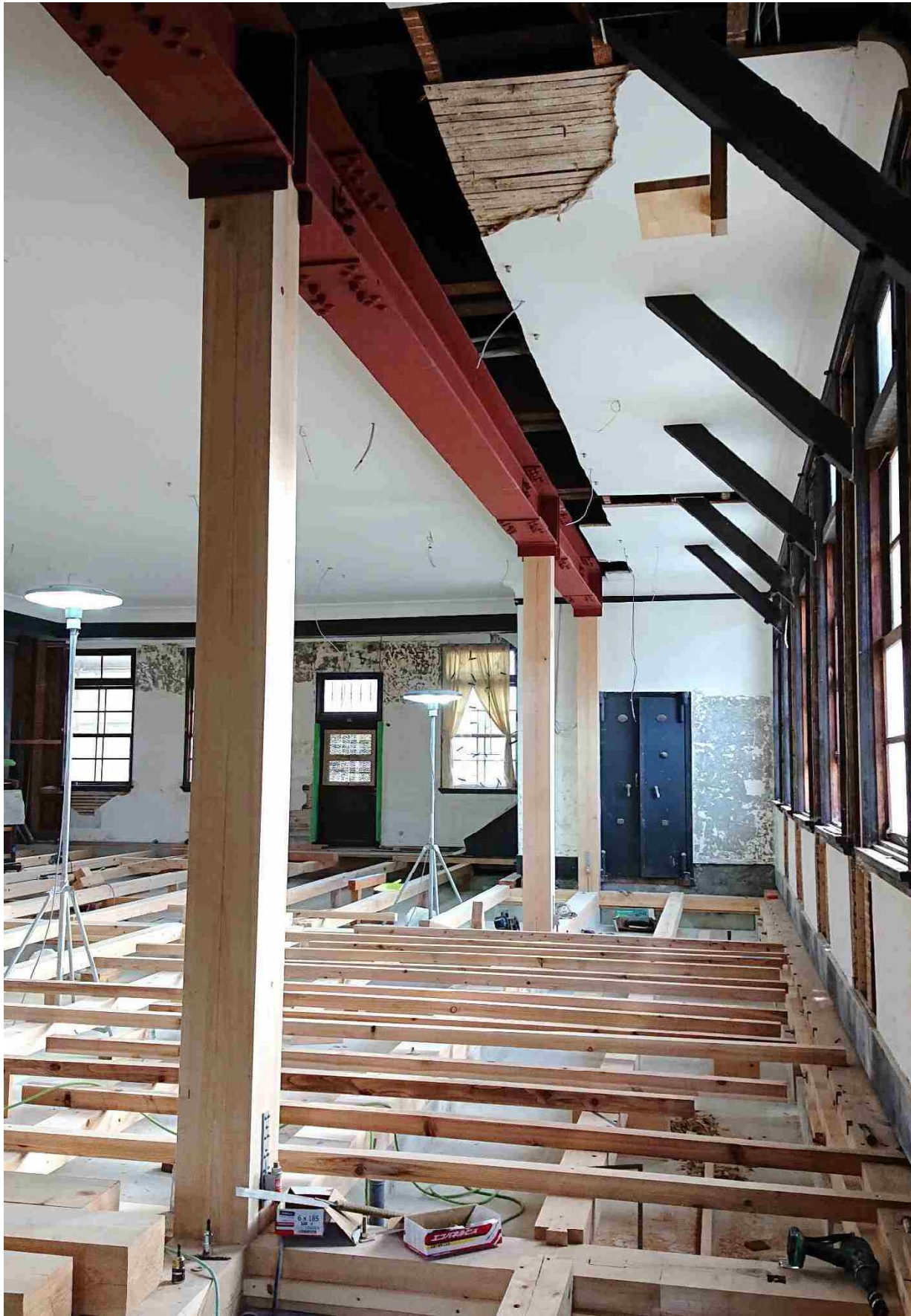
耐震補強のため、1階西側に新設した鉄骨の梁とそれを支える柱。2階旧議場と廊下との間の内壁の真下の位置にあたります。地震時に屋根や2階の荷重を地盤に伝達するだけでなく、建物の全体のねじれを防ぐ働きもします
