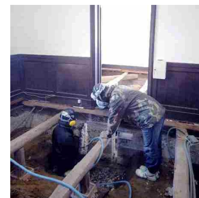
既存基礎コンクリートを切り出し、金沢工業大学で、実物を用いた実験も行いました
