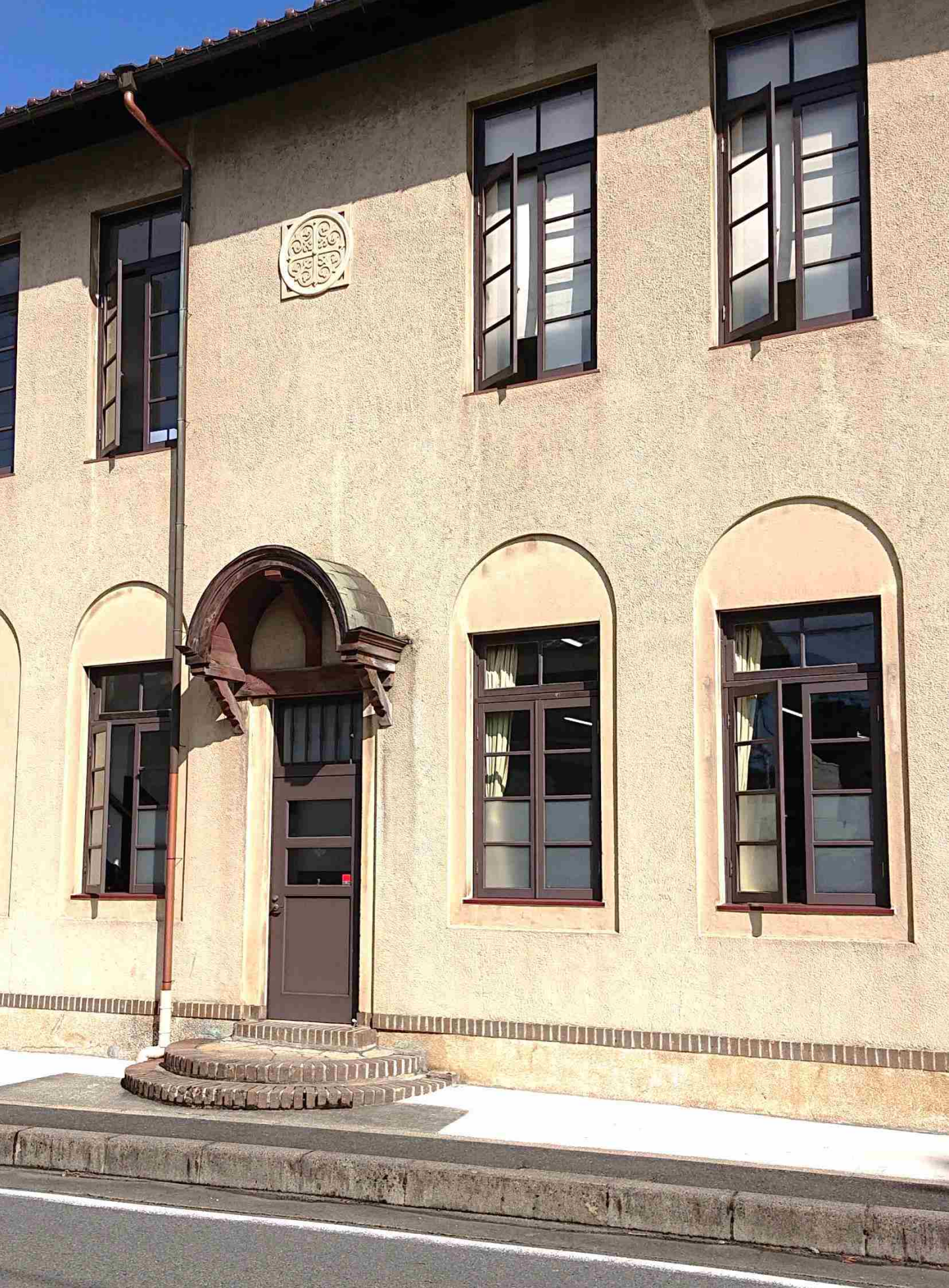
南面の出入口。凝った意匠は、洋風建造物の雰囲気をよく表しています。ちりめん街道への敬意が込められているとも言われています。外壁のモルタルは、耐火の目的もありました
