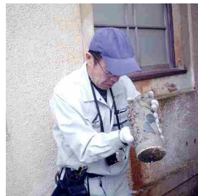
コア抜きした基礎コンクリート。無筋で、大きな石が混じるものもありました
