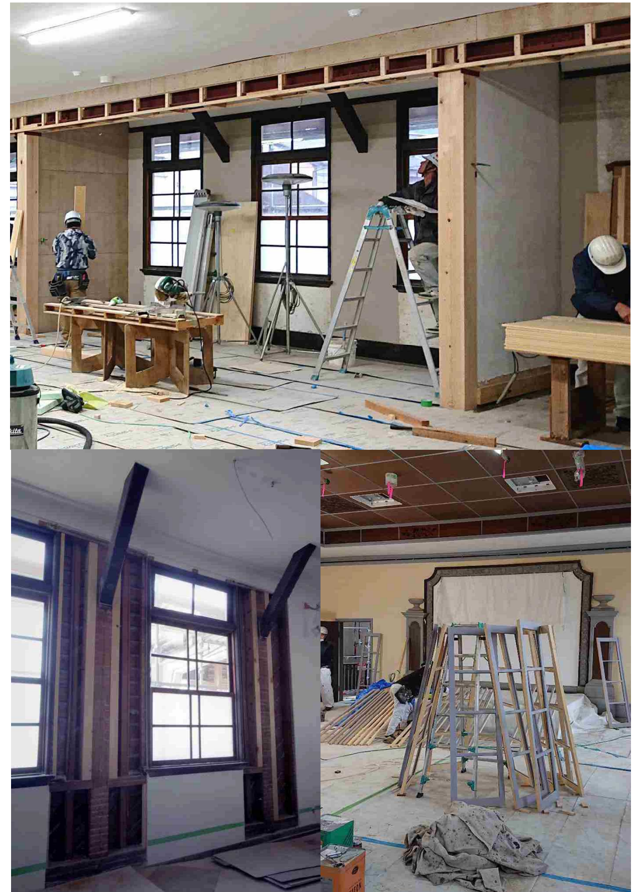
上／耐震補強で新設した鉄骨梁・柱・袖壁の仕上げ工事。既存のものと調和するように木と漆喰で仕上げました 左下／方杖が付く柱の折損を防ぐため、添木で補強しました 右下／屋外に接する窓の製作。上げ下げ窓から両開き窓に復原しました
