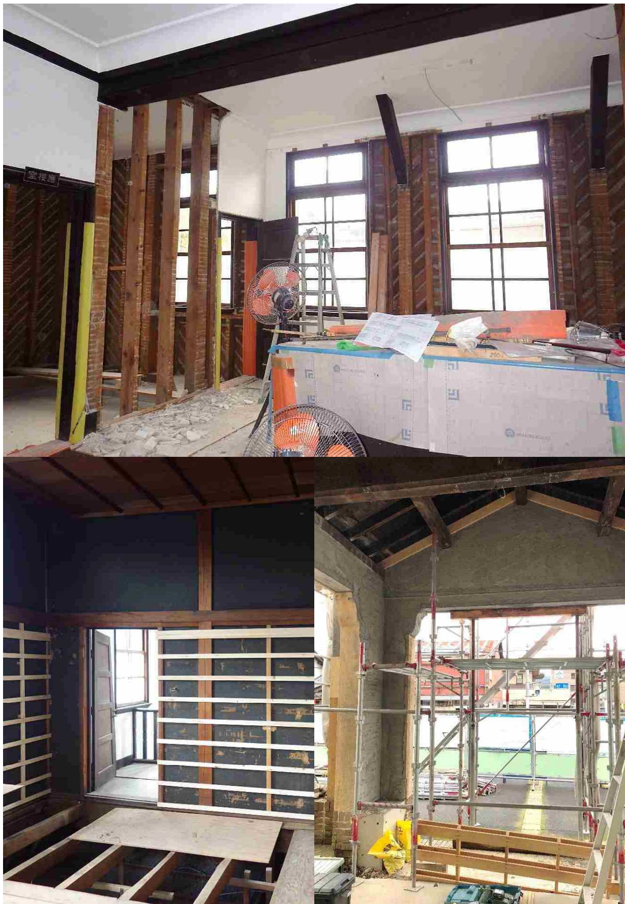
上／耐震補強の工事中。この後、1階北側居室部分には荒壁パネル、方杖が付く柱には添木を設けました 左下／2階南側居室。事務室とするため、クロスを張り、当初の砂擦壁の養生としました 右下／仕上げ前の車寄せ。仮設材が外れました
