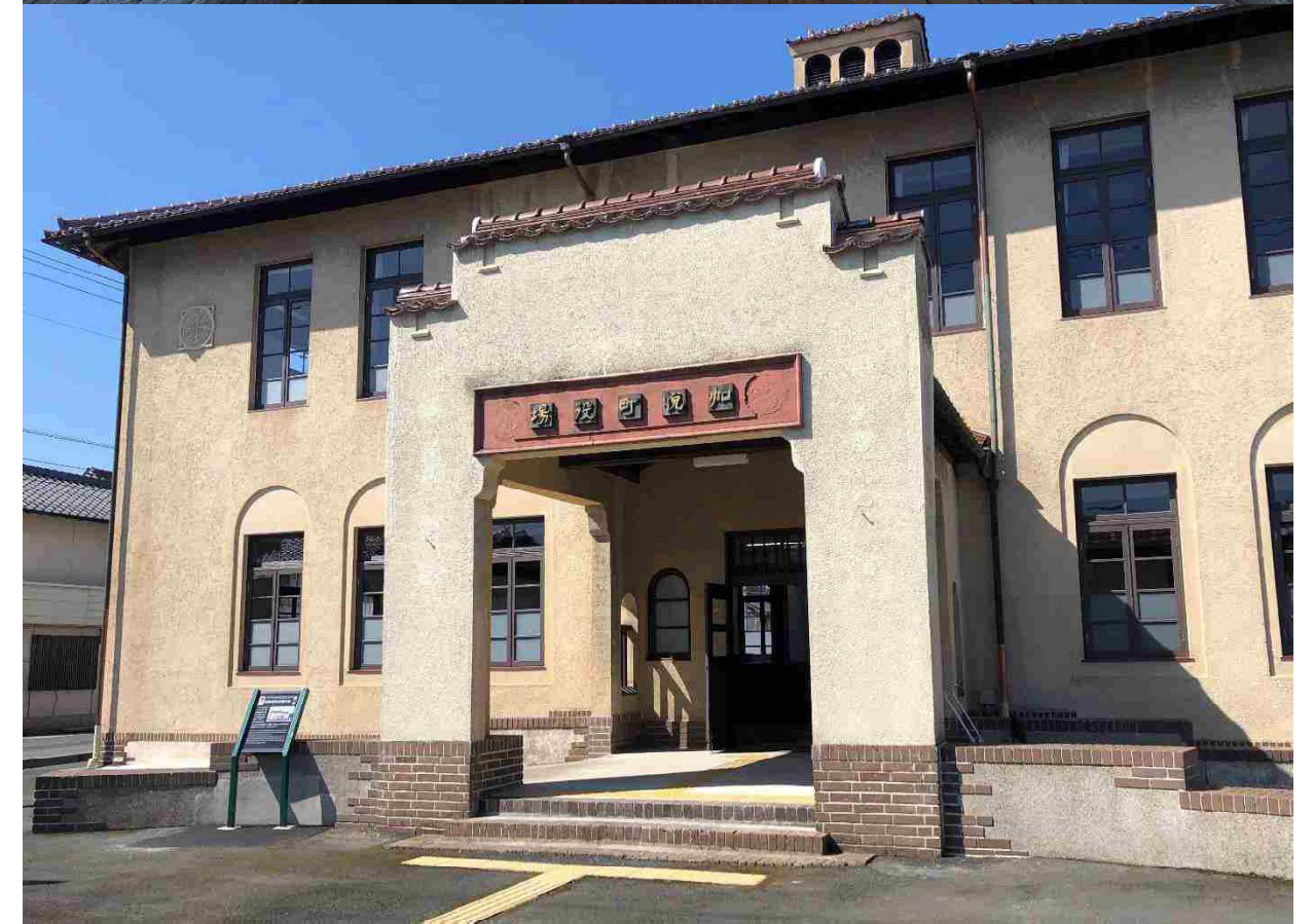
上／修理後の1階屋内。受付カウンター正面の腰板は当初のベニア（塩地の合板）です。混同されがちなラワン合板と比べ、当時の価格差が3倍以上ある高価な材でした 下／修理後の外観。外壁の大部分が当初のスタッコ塗で文化財的に貴重です
