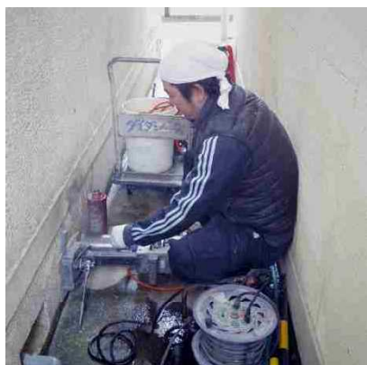
既存基礎コンクリートの状態を調べるため、一部を切り出しました（コア抜き）
