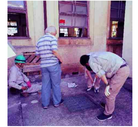
非破壊検査手法のシュミットハンマーを用い、基礎や外壁の圧縮強度を計測しました
