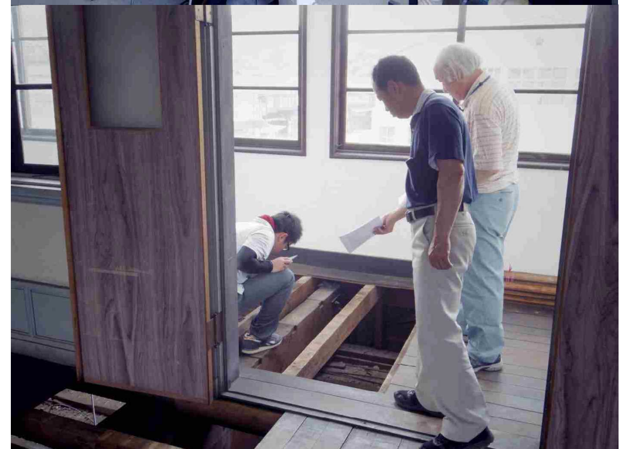
上／2018年7月の第2回耐震改修検討委員会のようす。この日から3日間、大規模な合同調査も実施しました 下／2018年6月の構造詳細調査のようす。2階の梁と1階の方杖との接合方法を確認しているところです
