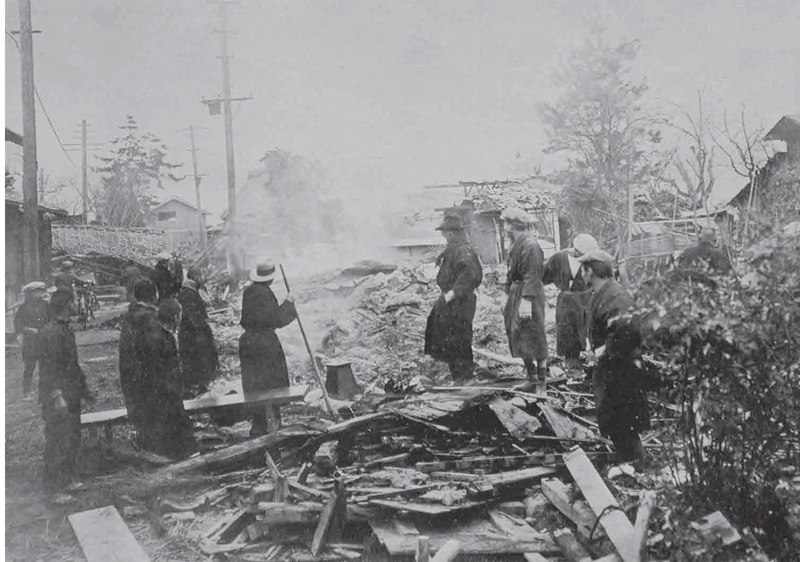
写真には「加悦村天神入口付近の惨状」と記されています
