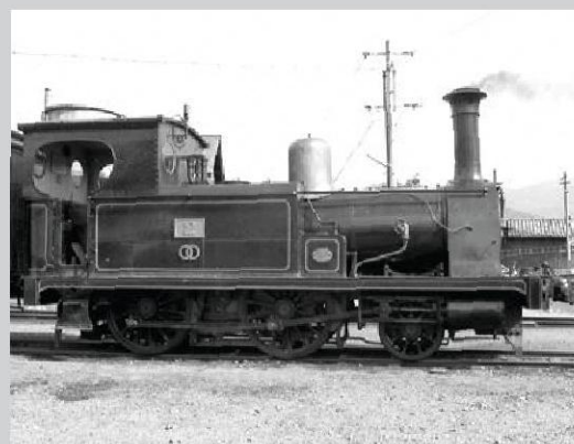
双輪マークが付いた2号機関車（昭和45年）
