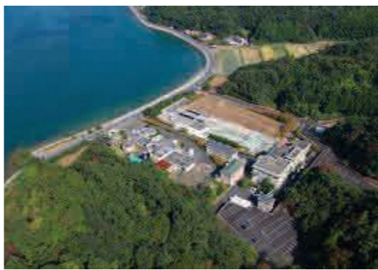
宮津湾浄化センターの航空写真（出典：京都府ホームページ）
