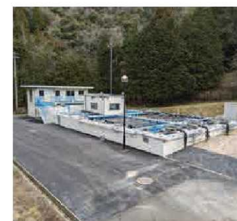
令和5年度に耐震化工事を終えた男山浄水場の沈殿池
