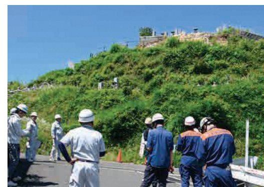
雨で斜面が崩落した現場を確認（藪後区内）
