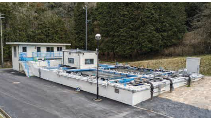
令和5年度に耐震化工事を終えた男山浄水場の沈殿池
