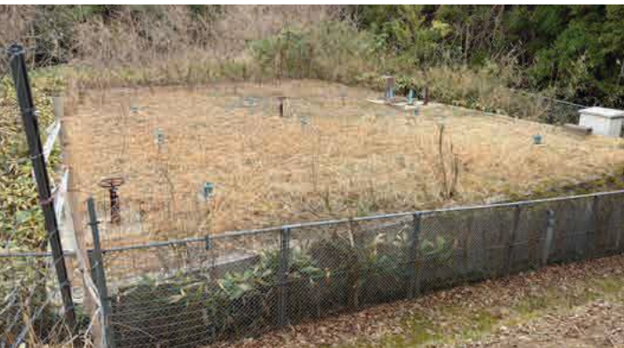
今後更新予定の男山浄水場の配水池
