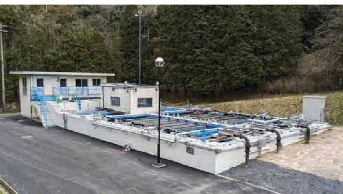
令和5年度に耐震化工事を終えた男山浄水場の沈殿池
