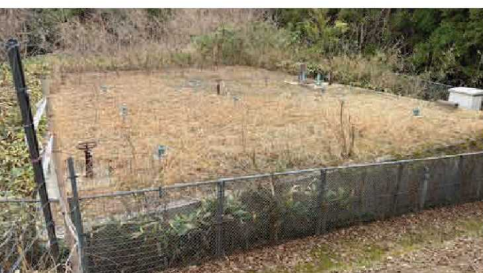
今後更新予定の男山浄水場の配水池
