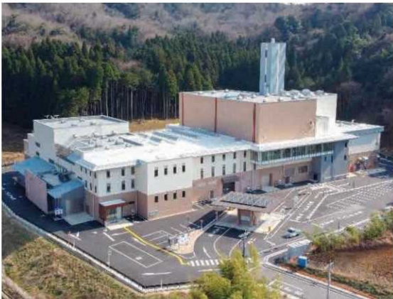
▲ 宮津与謝クリーンセンター 令和 2 年 4 月から処理対象ごみの全量受け入れを開始。メタンガス化施設を併設しており、ごみから発生したメタンガスを使用して発電することにより、温室効果ガスの削減に寄与しています。
