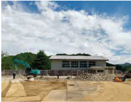
旧岩屋小学校の解体工事
