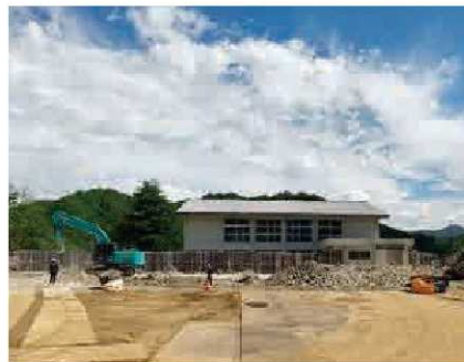
旧岩屋小学校の解体工事
