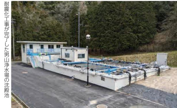
耐震化工事が完了した男山浄水場の沈殿池
