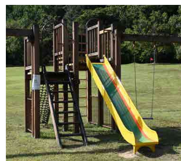
修繕した中型木製複合遊具
