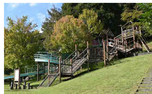
修繕した大型木製複合遊具
