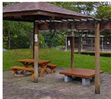
修繕した東屋のテーブル・ベンチと縁台
