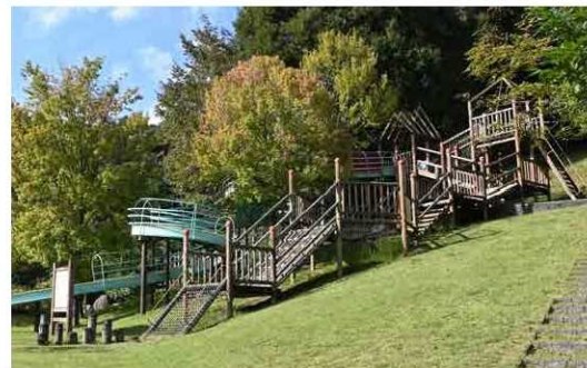
修繕した大型木製複合遊具
