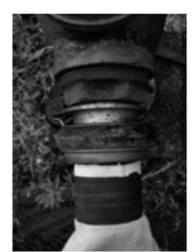
2 消火栓の結合部のキャップを左に回して外します。キャップの頭にハンドルをはめると回しやすくなります。
