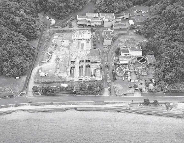
宮津湾浄化センター（同センター提供）
