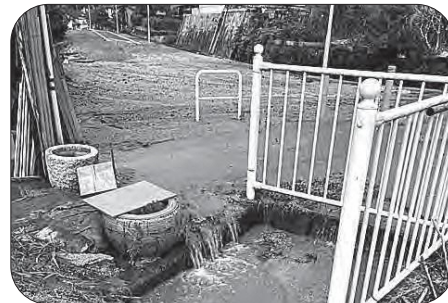
災害の被害状況
