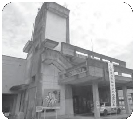
解体して認定こども園の建設を
