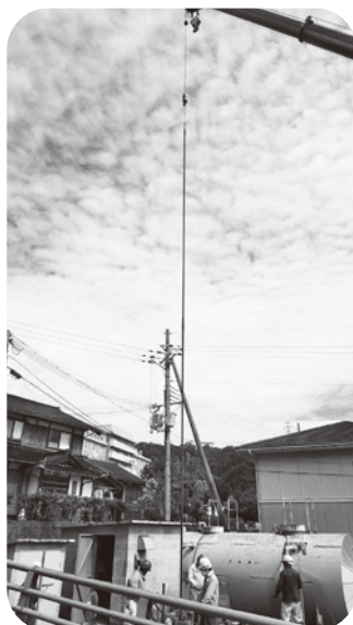
入れ替え中の湯湯ポンプ
