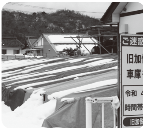
収納施設現在建設中
