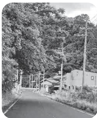
樹木がせり出した道路
