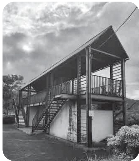
解体するトイレ棟
