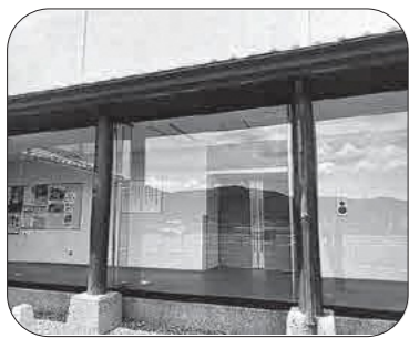
修繕された箇所
