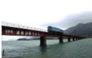
丹鉄由良川橋梁
