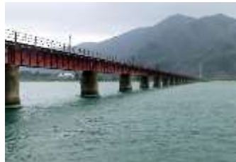
丹鉄由良川橋梁
