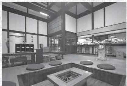
改修工事が完了したかや山の家
