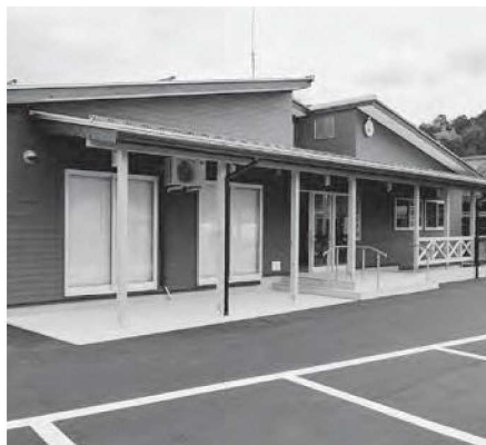
新築された温江地区公民館
