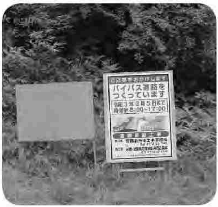
岩屋峠工事現場
