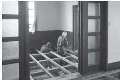
旧庁舎で木部の詳細調査を実施。白アリなどの虫による被害や腐朽、それらによる部材の欠損度合い、進行性のものかどうかなどを詳細に調査
