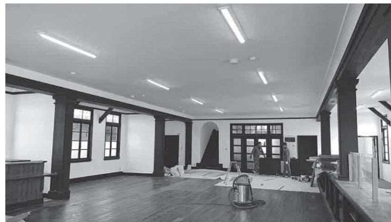
2月6日に撮影した1階の様子。写真左側（建物西側）の耐震補強のための鉄骨梁、それを支える柱、補強壁の仕上げが完了しました。写真右側（建物東側）の建築時の鉄骨梁と柱の仕上げに調和するよう漆喰と木材で仕上げられています
