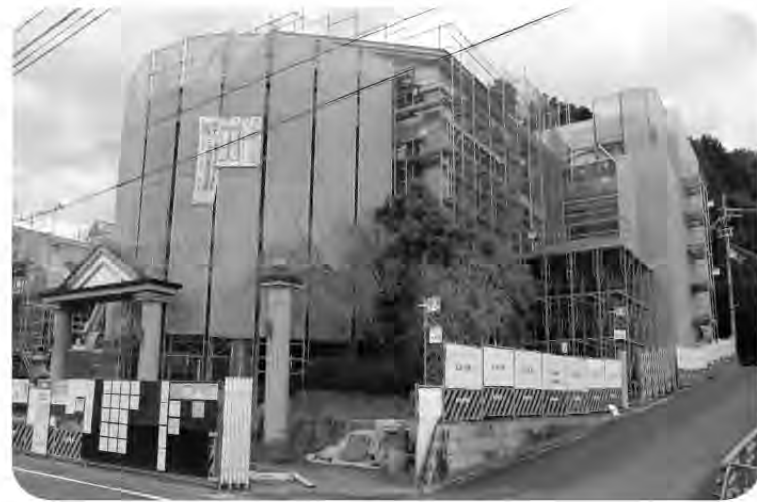
改装中のクアハウス
