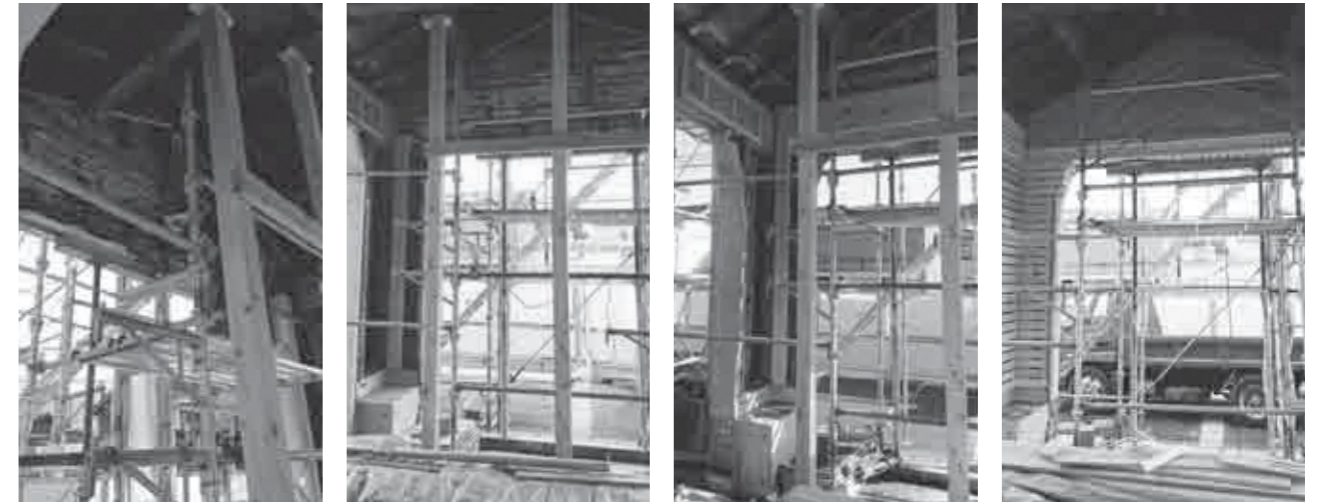
修理工事が順に進む車寄せ（右端が12月19日現在の様子）
