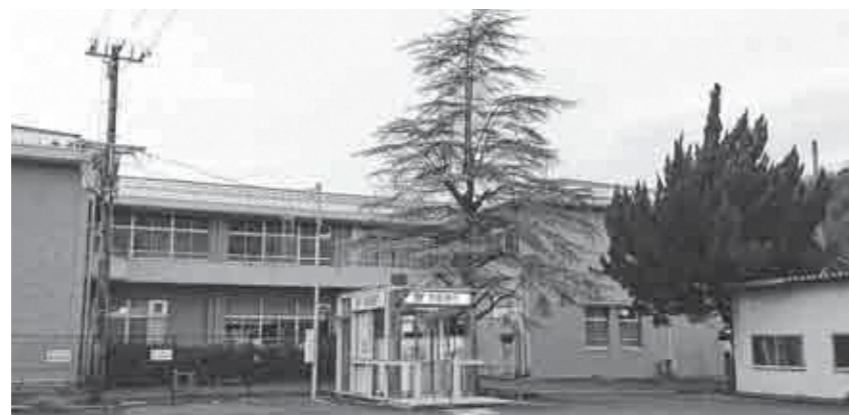
移設する電柱（写真左）。伐採するヒマラヤスギ（写真中央）。ヒマラヤスギ右隣のカイズカイブキも、一部を剪定します。現在ヒマラヤスギがある場所に電柱を移設します。
