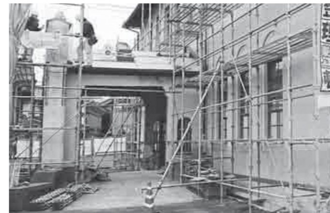
屋根部分を修理中の車寄せ
