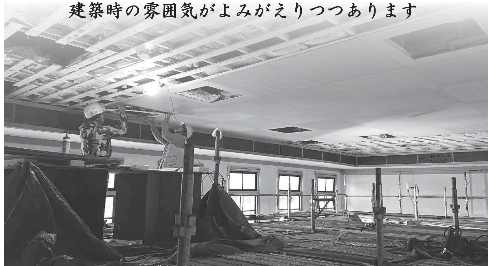
12月5日 修理中の2階旧議場の天井
