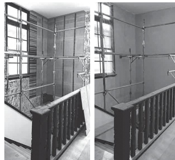
南側階段 左／耐震補強のための土壁パネルを施工中 右／仕上げの漆喰塗りの下準備（中塗り）後
