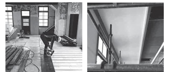
左／1階の床板を張る様子 右／2階旧議場の大津壁と折上げ天井の白漆喰塗り部分
