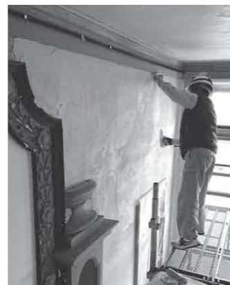
修理中の2階旧議場の漆喰壁。建築当初は薄いクリーム色（黄犬津）であったことが分かり、本工事で復原します。
