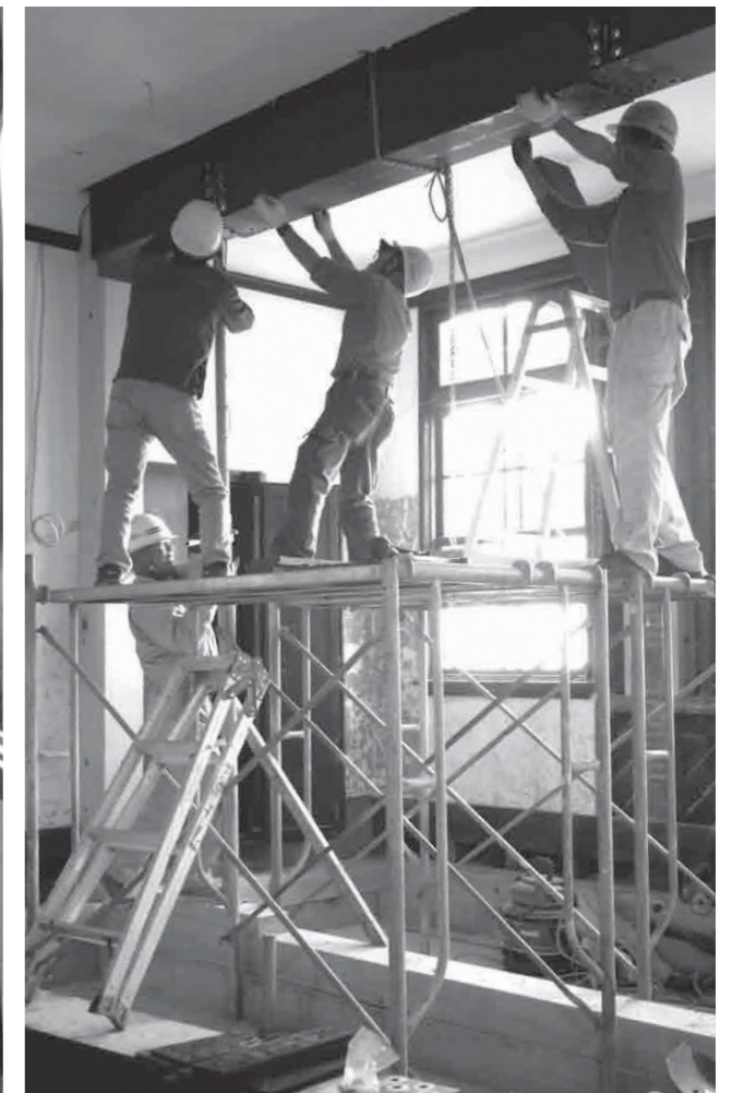
左・右 鉄骨の新設には、11月6日・7日の丸2日間を要しました。修理工事のため重機が入らず、人力での大変な作業となりました。
