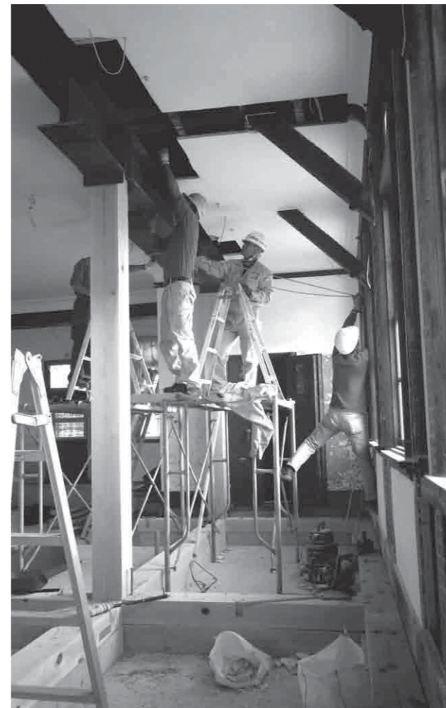
左・右 鉄骨の新設には、11月6日・7日の丸2日間を要しました。修理工事のため重機が入らず、人力での大変な作業となりました。
