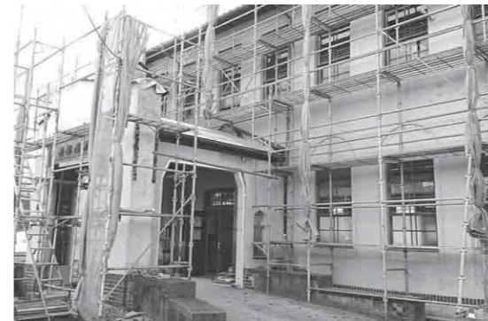
【足場が組まれた外壁】大規模に足場を組んだ機会を利用し、大屋根の状態も確認しました。雨漏りはありませんでしたが、大屋根の装飾にもなっている換気棟のアーチ型の窓枠が積層の木材でつくられていて、木部の経年劣化から、大雨の時などに雨水が建物内に入り込むことが分かりました。今回の工事で修繕します。
