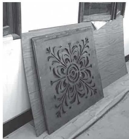
現存する建築当初の天井板
