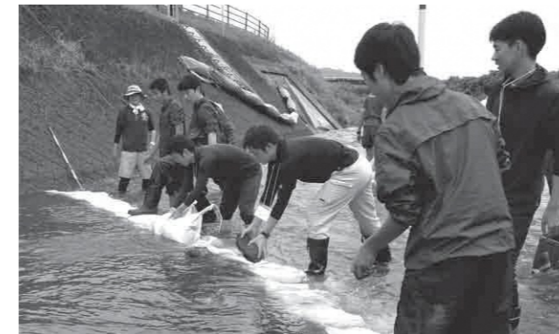
上/豊かな川づくりの実例を紹介する瀧さん 下/土のうを積み「水制」をつくり、水の流れを変える参加者（後野区の野田川にて）
