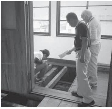
昨年6月の構造詳細調査。2階の梁と1階の柱との接合方法を確認しました
