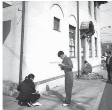
— 昨年3月の外壁調査。外壁のひび割れの位置、長さ、深さなどを調査
