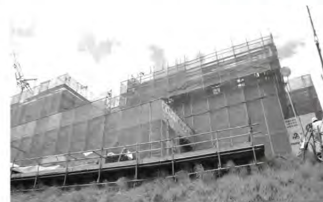
建設中のごみ処理施設
