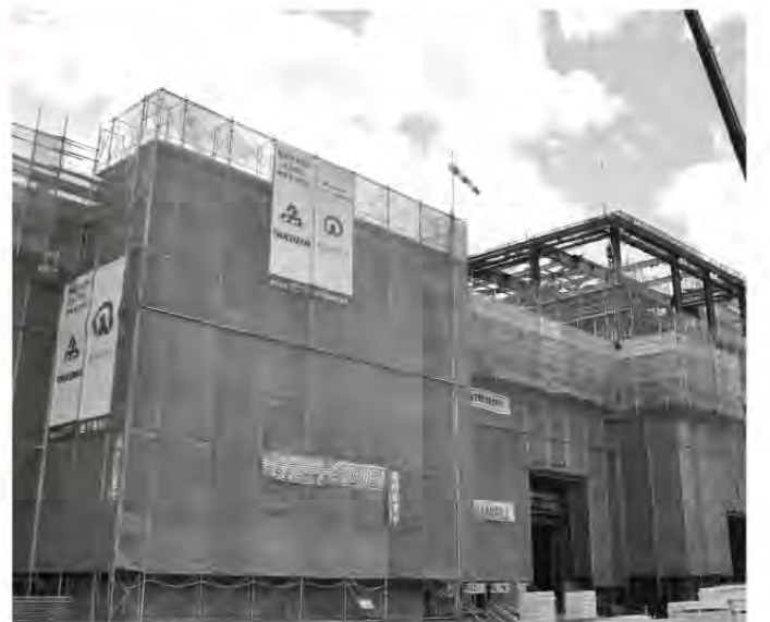
建設中のごみ処理施設
