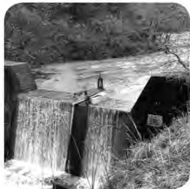
奥山川堰堤の現状
