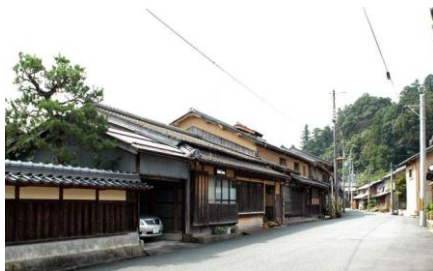
与謝野町加悦伝統的建造物群 保存地区
