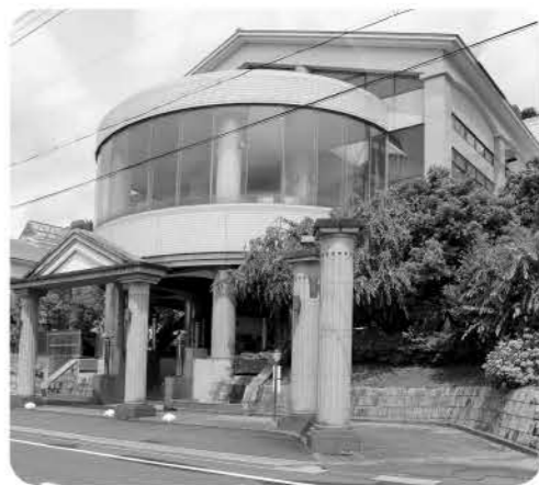
待たれるクアハウス改修工事
