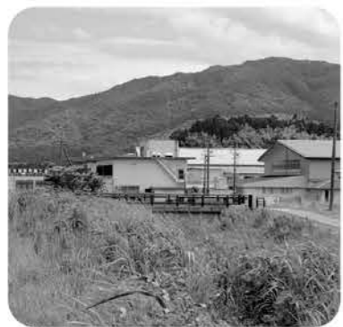
老朽化の進んだ公共施設
