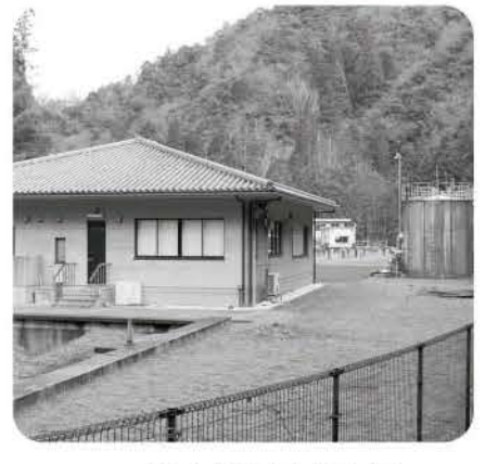
浄水場施設 (男山)
