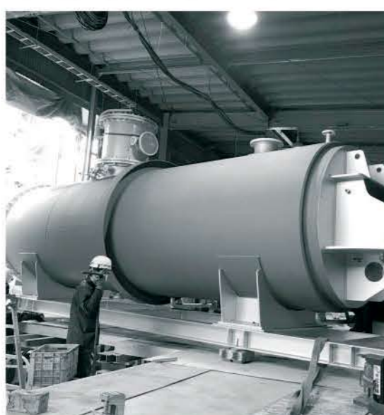
工事中有機物供給施設
