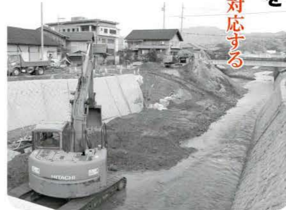
工事中の加悦奥川
