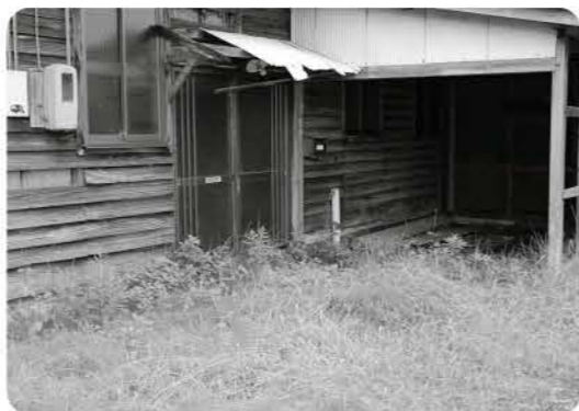
町内の空き家
