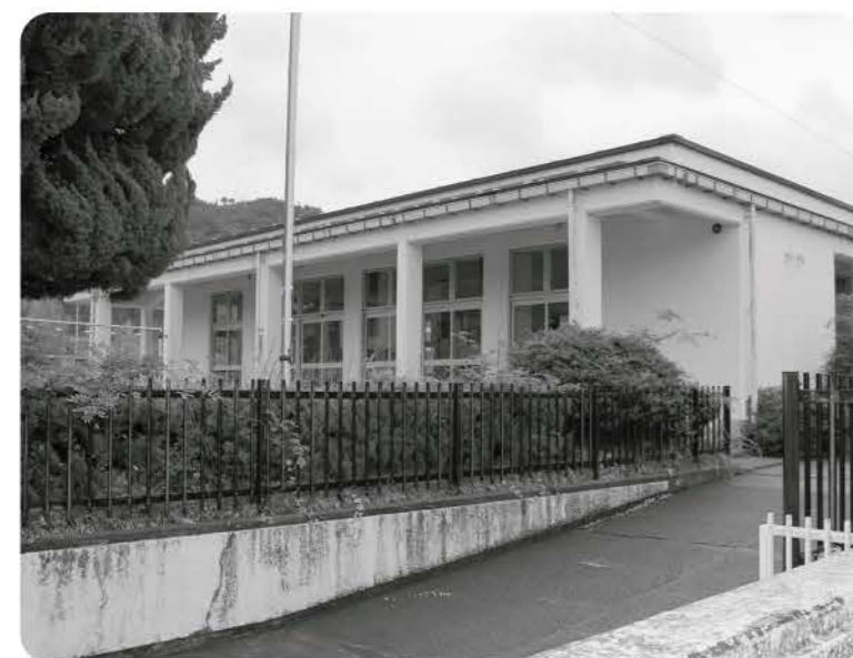
改修される旧岩滝保育所
