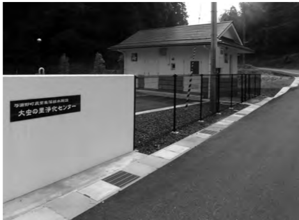
農集排浄化センター
