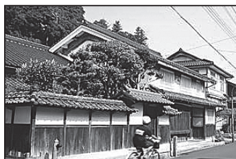
与謝野町加悦伝統的建造物群保存地区
