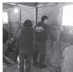
土壁補修体験の様子
