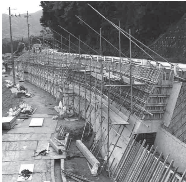
温江の工事現場
