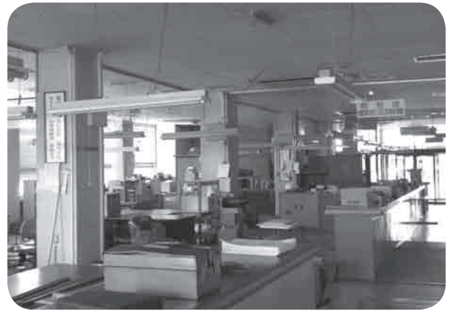
解体される野田川庁舎の現状
